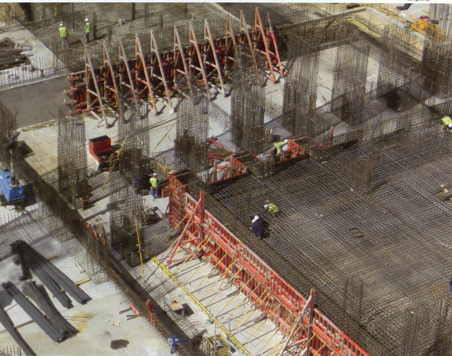
Arriba, planta de aparcamiento. Armado de pilares y losa. Abajo, a la derecha, construcción de la sala de pinturas, losa postensada y pantalla, muro, foro y contrafuertes.
